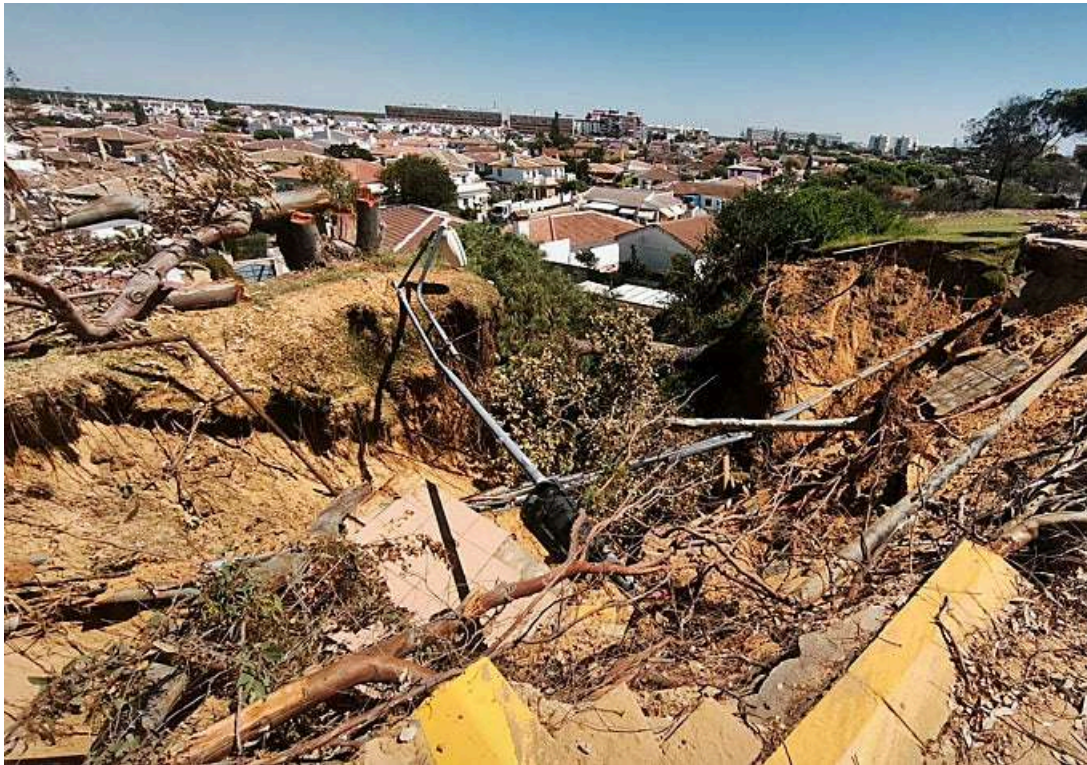
El enorme socavón provocado por la rotura de la tubería. (h24)
