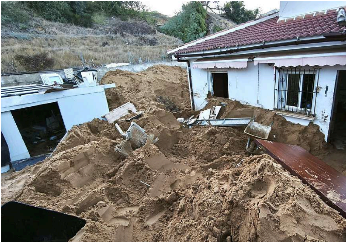
Toneladas de arena sobre la casa de José María. (h24)
